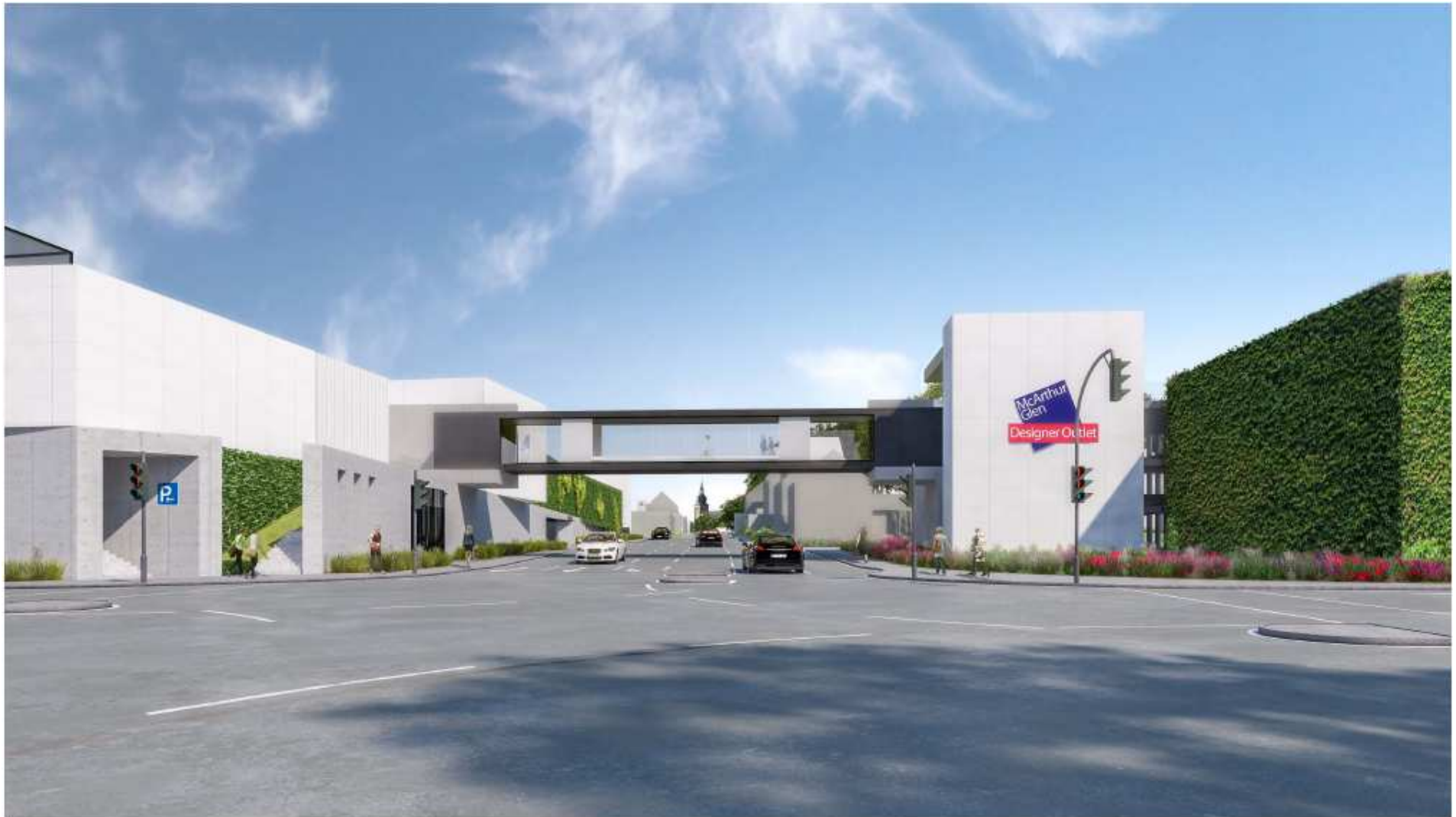
BLICKPUNKT 06 - BLICK VON KREUZUNG RINGSTRASSE / RADERSTRASSE RICHTUNG DOC
